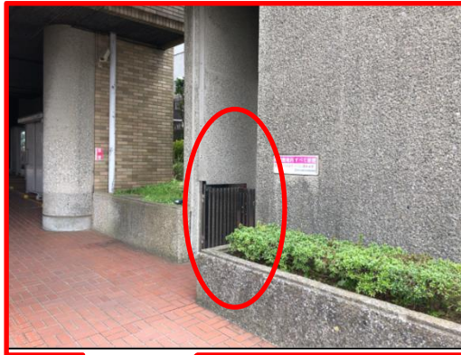
港南台駅側 外部階段から2階へ
